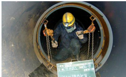
巻込鋼管(内挿管)立坑投入・既設管内引込み
